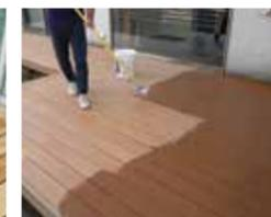
保護塗装剤を2回に分けて塗布して、1日乾燥させます。
