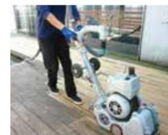
専用機械で汚れたデッキの表面を薄く削り落とします。
