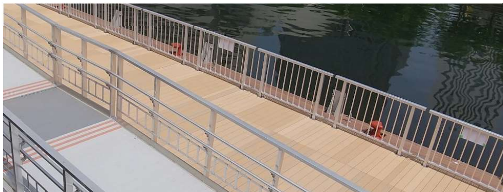
大阪 船着場 浮棧橋
