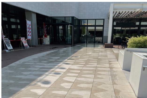
排水クリップを設置後
