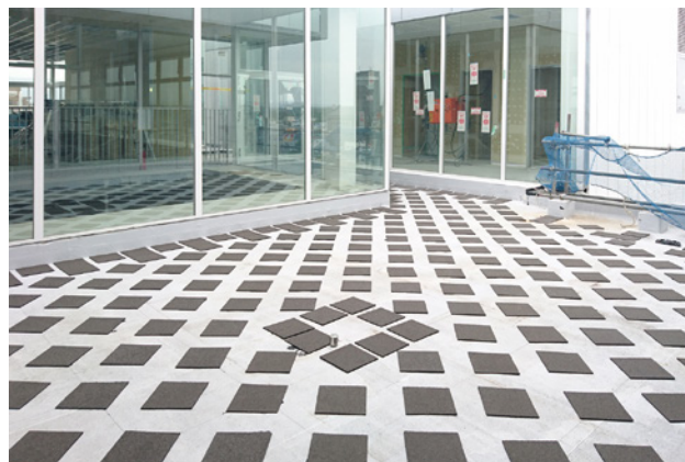
② アスファルト生型版6mmをエフレックス(Z)で接着する 注:エフレックスZ ライトグレー 変成シリコーンエポキシ樹脂系接着剤333ml
