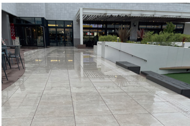
排水クリップを設置前
