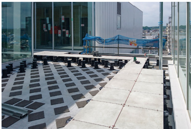
④ プラ束の天端に緩衝用EPDMマットと接着剤を敷き、タイルを敷き並べる。
