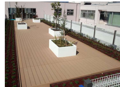
茨城県内某病院 屋上デッキ
