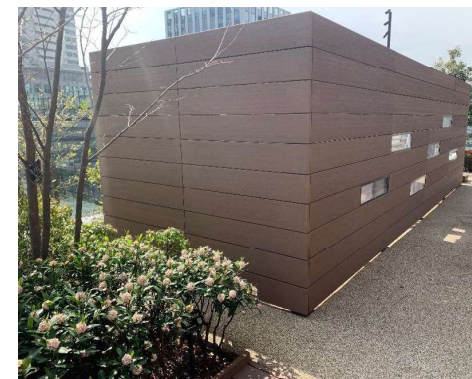
▲5F養蜂場スキップテラス（エア・ルーバー）
