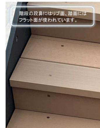
階段の段鼻にはリブ面、踏面にはフラット面が使われています。
