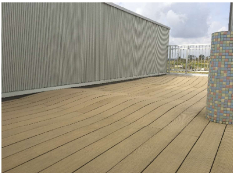
【写真】再生木デッキの吸水により伸びてしまい、太鼓橋状態になってしまったウッドデッキ床。
