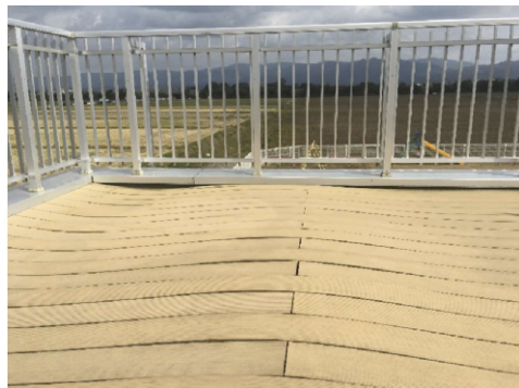
【写真】再生木デッキの吸水により伸びてしまい、太鼓橋状態になってしまったウッドデッキ床。
